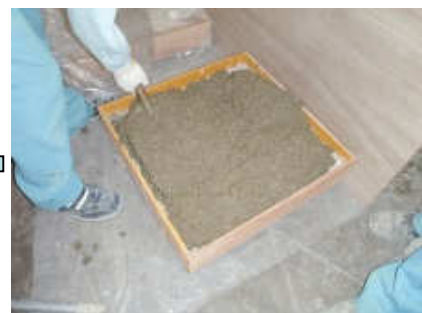
型枠へ打ち込み
